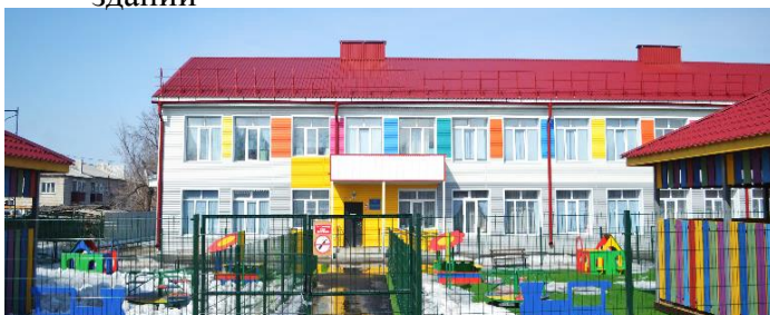
Детский сад «Солнышко» по ул. Ленина Замена кровли, фасада, водопровода, канализации, монтаж уличных игровых площадок
