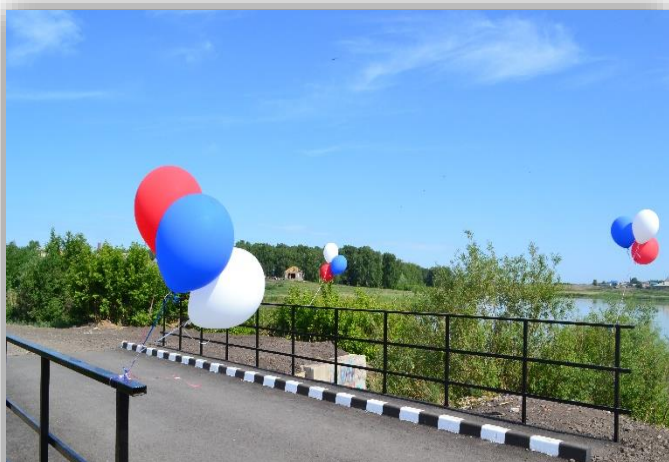
Мост ул. Путиловская с. Топчиха
