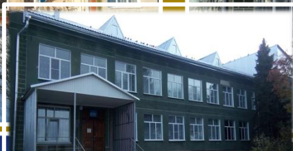
Капитальный ремонт крыши, замена окон Зиминской ООШ 2020 год
