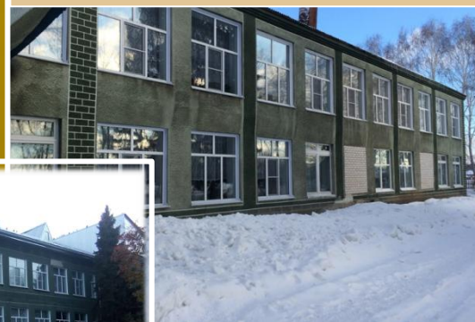
Замена окон Сидоровской СОШ 2020 год
